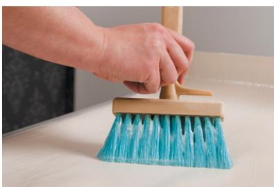
10. Для бумажных обоев рекомендуем использовать клей Kiilto Master или Master Light, используя специальную щетку или устройство для нанесения клея. Убедитесь, что по всей обратной стороне обоев клей нанесен равномерно.
