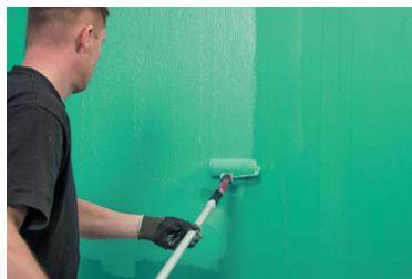
5. Нанесите второй слой гидроизоляционной смеси Fiberpool, дайте высохнуть в течение 6-12 часов до изменения цвета, прежде чем приступить к укладке плитки.
