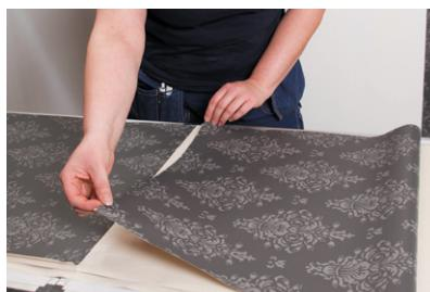
11. Сложите обои и дайте им пропитаться, согласно инструкции производителя, в среднем 5-10 минут. После пропитки откройте верхнюю часть полотна и закрепите на стене, соблюдая вертикальную линию или край предыдущего полотна.
