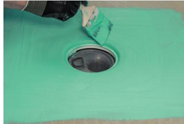
**10.** На всю поверхность вплоть до зажимного кольца наносится состав Kiiito Fiberpool.
