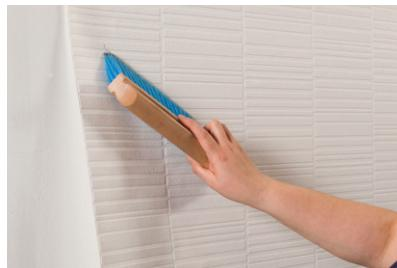
19. Обои под покраску проглашают шпателем для обоев от середины полотна к краям. Обои можно красить через 12 часов, используя подходящую для этого краску.
