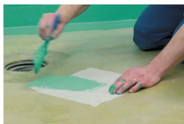
3. Изоляцию напольного стока можно произвести при помощи закрепленных крест-накрест кусков ленты для упрочнения углов Kiilto. Приложите материал к полу и промажьте гидроизоляционной мастикой. Незамедлительно прикрепите второй элемент крест-накрест к первому и еще раз промажьте гидроизоляционной мастикой.
