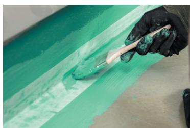
2. Укрепите углы, швы и стыки с помощью упрочняющей ленты Kiilto, для этого «утопите» ее в свежий слой Fiberpool и сверху нанесите еще один слой Fiberpool валиком или кистью.
