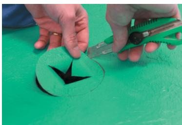
**6.** После высыхания мастики в области слива (диаметр не менее 40 мм), вырежьте небольшое отверстие, таким образом, чтобы вырезанный край выдавался из стока через трап (см. инструкции производителя). Толщина гидроизоляции в области трапа в полу должна составлять минимум 1,2 мм.
