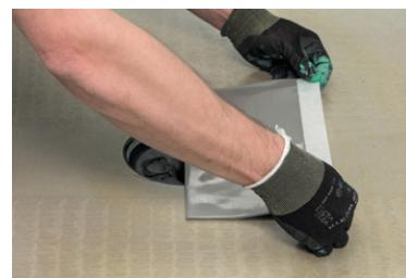
**8.** Уплотнение стока в полу можно осуществить при помощи самоклеящейся ленты для стоков Kiiito Kaivolaippara. Ее крепят к высохшей поверхности основания и аккуратно приклеивают, снимая верхний слой. Во фрагменте вырезается отверстие, соблюдая инструкции производителя стока, а затем устанавливается зажимное кольцо.
