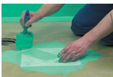
4. Нанесите гидроизоляционную мастику вокруг стока по площади 40 на 40 см и прикрепите на этот слой куски ленты крест-накрест. Для установки уплотнительных элементов стоков следуйте инструкции производителя трапов.
