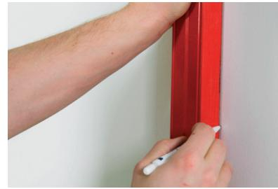
9. Правильность расположения каждого первого полотна стены следует проверять уровнем или отвесом.
