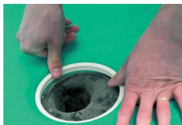
**7.** Установите подходящее для трапа зажимное кольцо и по возможности отрежьте край гидроизоляционного уплотнителя, выдающийся из-под кольца.
