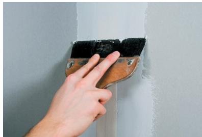
5. При креплении ленты для швов на основание наносится шпатлевка, на влажной поверхности которой крепится лента, которую также следует обработать шпатлевкой поверх.
