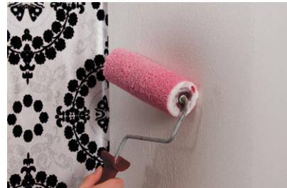
14. Флизелиновые обои готовят к поклейке другим способом. Им не нужно пропитываться, так что клей для стен Kiiitto Master Deco или Kiiitto Master Pro можно наносить сразу на стену, используя валик или щетку. Нанесите клей равномерно на площадь равную 1-2 полотнам.
