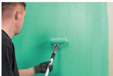
4. Нанесите смесь Fiberpool по всей стене и дайте высохнуть в течение минимум 2 часов до изменения цвета. На стенах в местах крепления шурупов также может бытьложен укрепительный материал, или они могут быть заделаны, например, при помощи готовой шпатлевки Kiilto LW.
