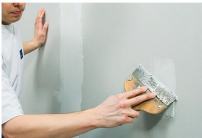
4. Отверстия от шурупов, швы и углы на новых поверхностях стен обрабатываются готовой шпатлевкой Kiilto J или Kiilto R.
