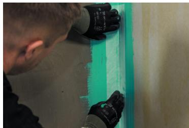
2. Всегда перемешивайте гидро-изоляционную мастику перед использованием. Укрепите углы, швы и стыки разных материалов с помощью упрочняющей ленты Kiilto, для этого «утопите» ее в свежий слой Fiberpool и сверху нанесите еще один слой Fiberpool валиком или кистью.
