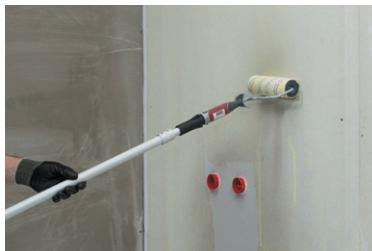
1. Загрунтуйте сухую и чистую от пыли поверхность стен грунтом Kiilto Fiberpool Primer. Kiilto Fiberpool Primer разбавить водой в соотношении 1: 1. Дать грунту высохнуть в течение, по крайней мере, 1 часа до начала гидроизоляционных работ.
