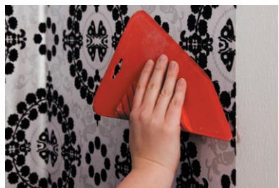
16. Используя шпатель для обоев, выгоните воздух из-под полотна. Возможные пятна от клея следует удалить немедленно сухой, чистой тканью.
