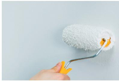
8. Базовое покрытие грунтовкой Start Primer, Primer, Light Primer выровненной поверхности до начала отделочных работ облегчает последующие задачи и удаление покрытия при следующем ремонте.
