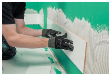
6. Начните укладку плитки на стены второго ряда плитки снизу, отступив не менее 10 см от пола. При укладке плитки используйте клей Kiilto Pro Fix.
