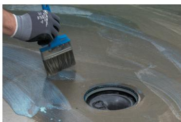
1. Загрунтуйте сухую и чистую от пыли поверхность пола грунтом Kiilto Fiberpool Primer. Kiilto Fiberpool Primer разбавить водой в соотношении 1:1.
