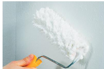
20. Стекловолоконные обои крепятся клеем для стекловолоконных обоев Kiiitto Master Pro, Master Deco. Нанесите Kiiitto Master Pro, Master Deco валиком равномерно на стену, на площадь одного полотна.
