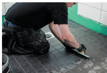
**13.** Затирка для швов Kiiito Saumalaasti наносится резиновым шпателем до полного заполнения швов. Лишняя затирка, оставшаяся после нанесения, смывается губкой через 15-30 минут. Губка должна быть слегка влажной, чтобы лишняя вода не изменила оттенок швов. Швы настенной плитки можно формировать, используя специальный уплотнитель для шва, который идет в комплекте.
