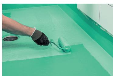
5. Нанесите второй слой Fiberpool, дайте высохнуть в течение 6-12 часов до изменения цвета, прежде чем приступить к укладке плитки. Проверьте плотность покрытия. Общий расход смеси должен составить минимум 1 кг на  $\text{м}^2$  в два слоя, а толщина слоя — 0,5 мм.
