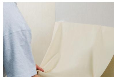
3. Если слоев обоев несколько, лучше всего отделять по слою за раз. Моющиеся обои следует обработать, например, наждакной бумагой. Более плотный пластиковый слой должен быть удален перед нанесением средства.
