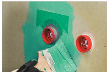
3. В местах выхода труб можно использовать готовые уплотнители для труб, или их можно вырезать из ленты для упрочнения углов Kiilto. Лента крепится на слой Fiberpool и сверху промазывается слоем мастики.
