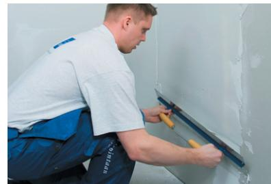
6. Для выравнивания стен используются Kiilto LK, LH, SH, WSH или готовые шпатлевки Kiilto LF, LM, E, R. Материалы наносятся широкой стальной штукатурной кельмой или стальным шпателем. Также возможно механизированное нанесение.
