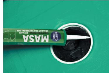
**11.** Место соединения зажимного кольца и трапа может быть уплотнено при помощи состава KiiltoFix Masa, который проверен на совместимость с сантехническими трапами.
