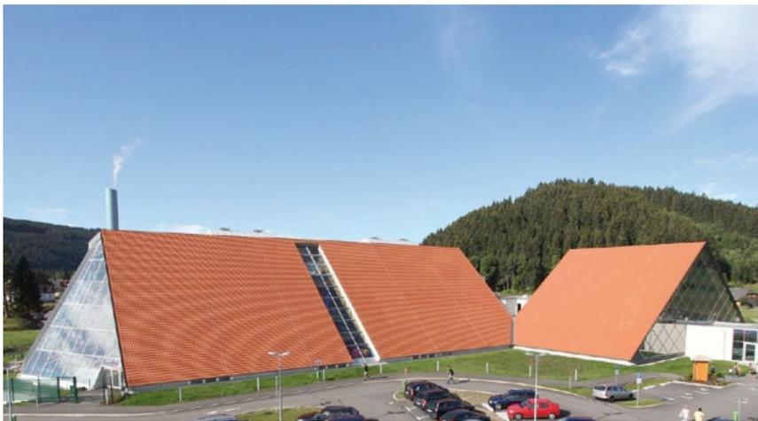
Große Ziegeldächer setzen spezielle Lösungen voraus: Im Winter 2011/2012 stauten sich Schnee und Eis an den Traufen rund sieben Meter hoch. Mit rund 6 Tonnen Schnee pro laufenden Meter Traufe muss im Extremfall gerechnet werden. Deshalb wurde bei diesen Ziegeldächern mit ihren großen Sparrenlängen auf Schneefangsysteme komplett verzichtet. Der Schnee darf ungehindert abrutschen. Bild oben: Die Entwässerung des Daches übernehmen rund um das Gebäude große Pflasterinnen.
