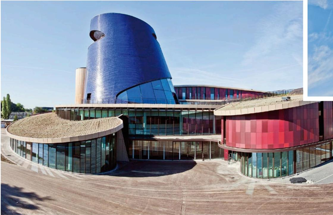
Nachhaltigkeit in jeder Hinsicht charakterisiert diesen auffälligen Bau: eine luftdichte Gebäudehülle, Dreifachverglasung, verstellbarer Sonnenschutz, mechanische Belüftung mit Wärmerückgewinnung und Wärmepumpe, begrünte Dächer und energiebewusste Beleuchtung werden ergänzt durch den weithin sichtbarsten Vertreter: einen flachen, azurblauen Tondachziegel.
