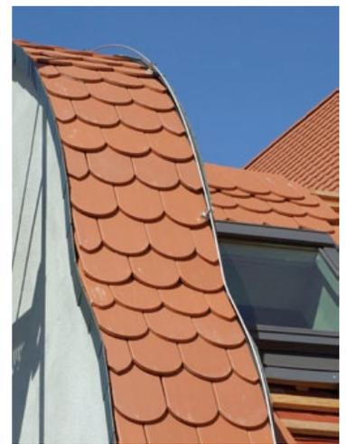
Landratsamt Würzburg: großflächige Dachsanierung mit Koramic-Bibern. Rechtes Bild: Mansardknick durchgedeckt mit Mansardbibern. Rechtes Bild, außen: Gewölbte Biber für Mansardknick und Schmuckgiebel.
